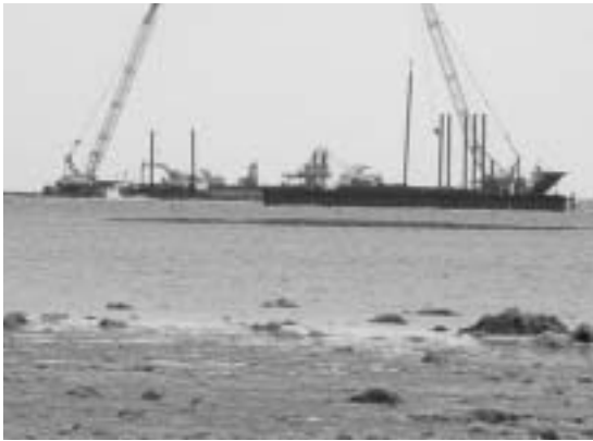
海上部分の埋立を行っている工事船
